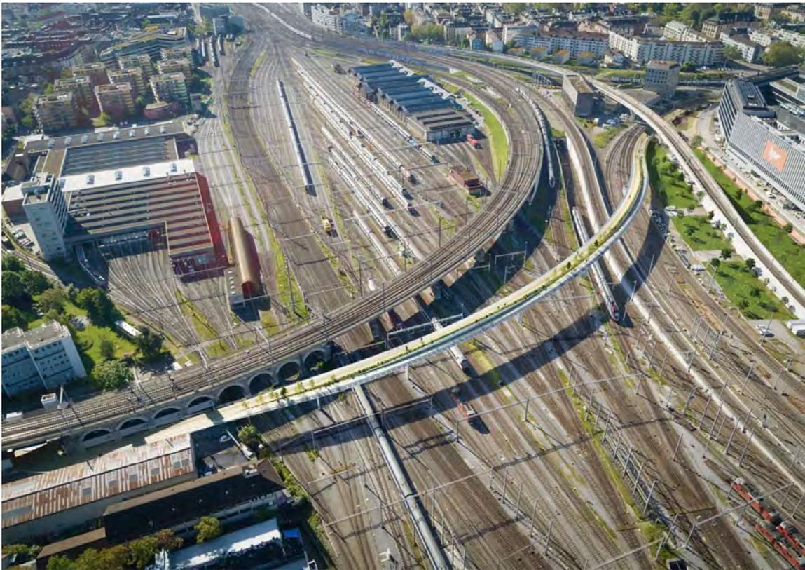
Die geplante Franca-Magnani Brücke von der Geroldsstrasse bis zur Lagerstrasse soll die Quartiere 4 und 5 miteinander verbinden. Der Bau soll 530 Meter lang und bis zu 6,5 Meter breit werden. Im rund 10 Meter breiten Mittelteil der Brücke wird ein Grünstreifen den Fussweg vom Veloweg trennen.
